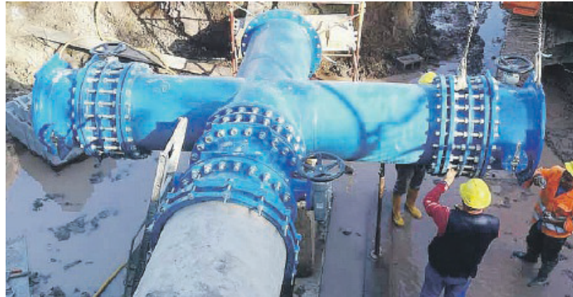
Costruzione nuova rete idrica
